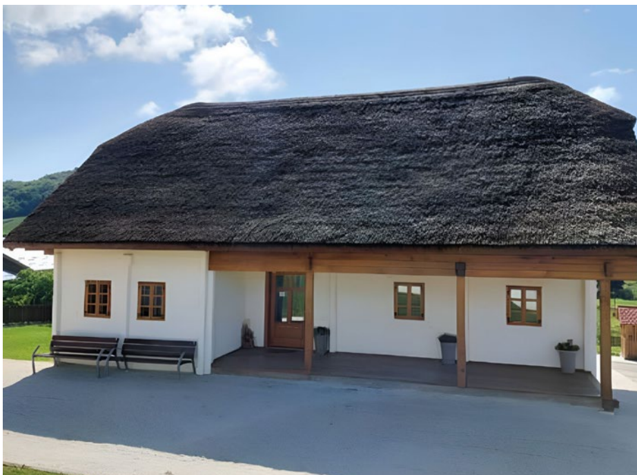
Obnovljena rojstna hiša Gjura Prejca v Desiniću. Foto: Občina Desinić, 2025
